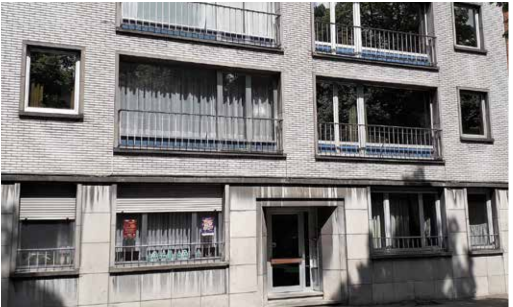
Appartementsgebouw met glasalplaten
