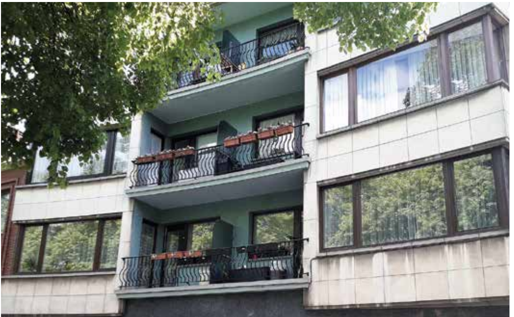
Appartementsgebouw in Robbedoesstijl aan de Briandlaan
