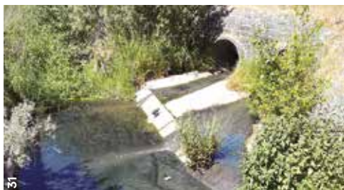
De tunnel van de Broekbeek en zijn samenvloeiing
