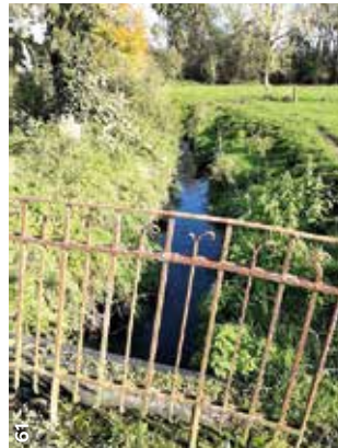
De brug voor de Neerpedhoeve
