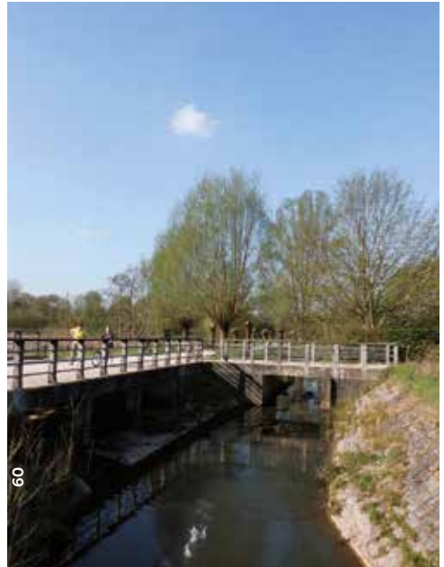
De brug over de Pede
