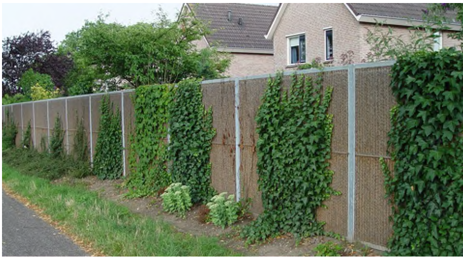
Figuur 37: Voorbeeld van een geluidsmuur met kokosvezel en bedekt met klimop (Techni-contact, 2023)
