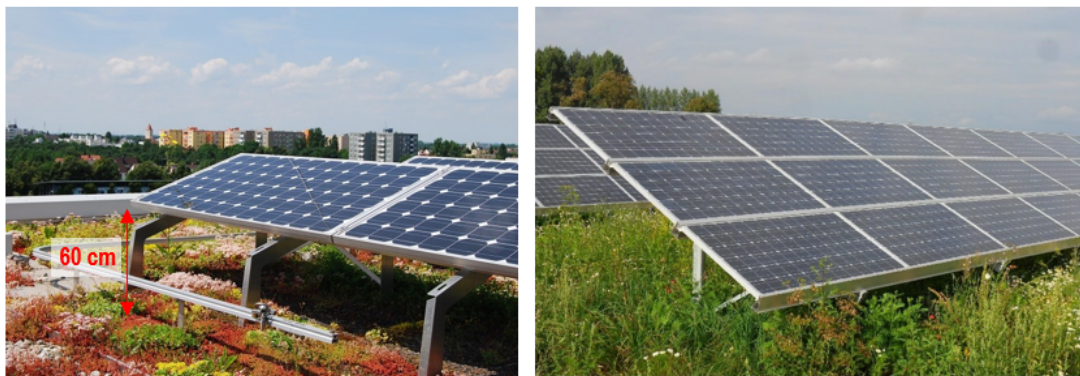
Figuur 39: Illustratie van de verhoging van de onderkant van de fotovoltaïsche panelen (links) en een intensief dak met kruidachtige vegetatie (rechts) (Ecovégétal.com, geraadpleegd op 15/11/2022)
