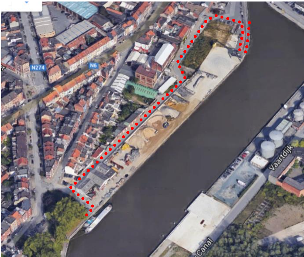
Figure 107 : Vue sur la zone où l'ICR canal est dévié de son axe de circulation en situation actuelle (Google Maps, Avril 2016)
