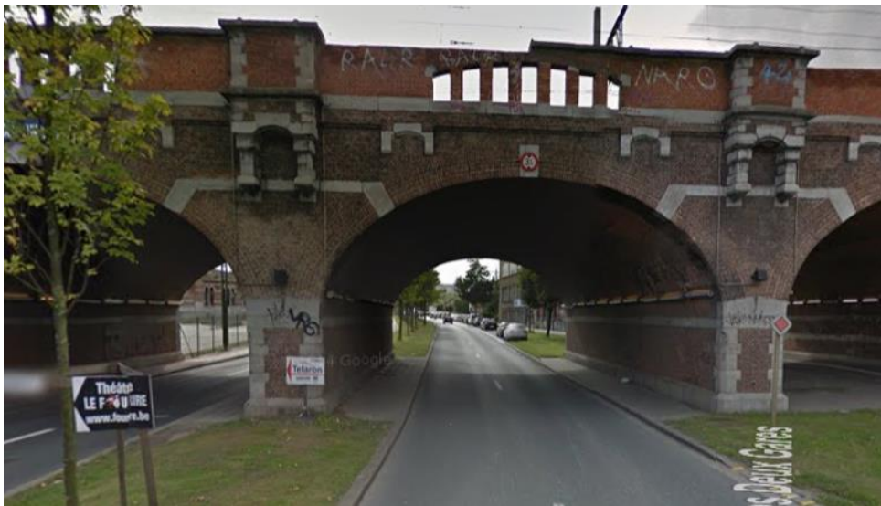
Figure 82 : Vue sur le passage sous voie du boulevard Industrielle
