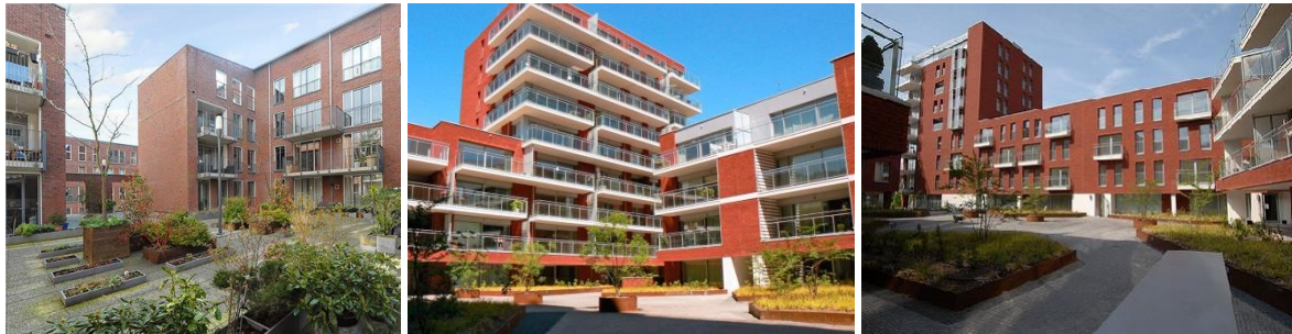
Activités dans le socle au rez-de-chaussée et logements au-dessus
