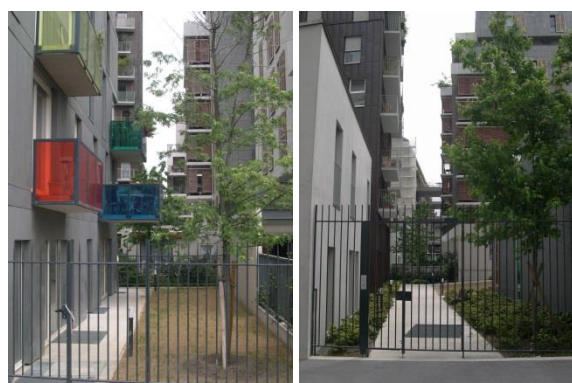
Des espaces privés en intérieurs d'îlots, grillagés...
