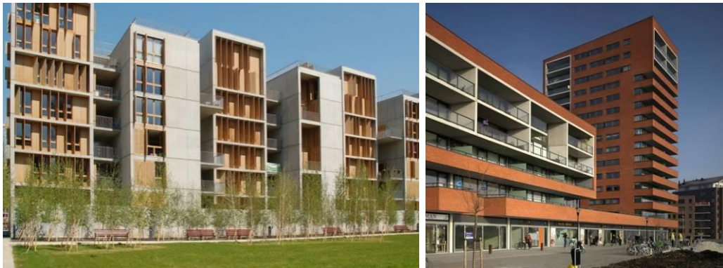
Front bâti extérieur constitué par du logement, encerclant un socle en rez-de-chaussée
