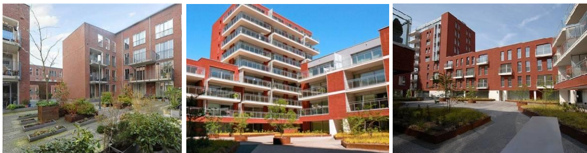
Front bâti extérieur constitué par du logement, encerclant un socle en rez-de-chaussée
