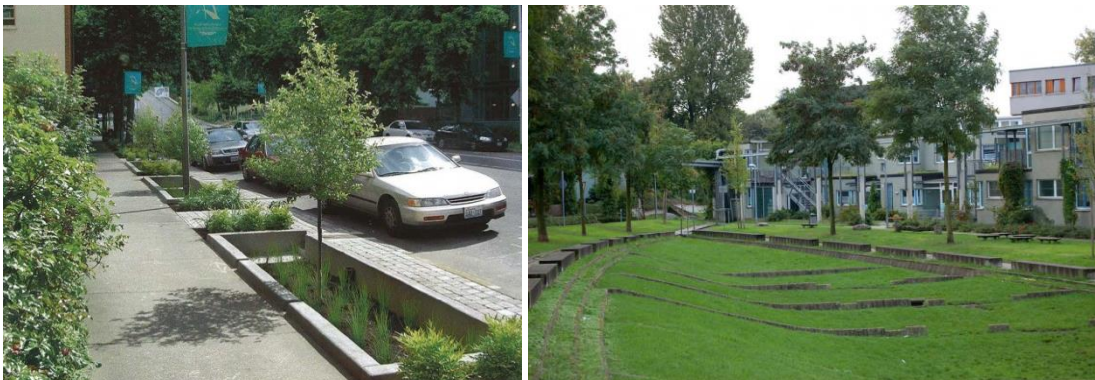
Aménagement d'un parc linéaire, support de la trame verte et bleue du quartier (système de rétention en voirie, Portland) (zone inondable, Freiburg)
