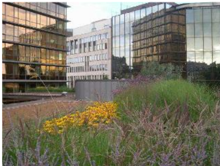
Figure 25 : Toiture semi-intensive, immeuble de bureaux à Ixelles (Arch-paysagiste : Bernard Capelle 2003)
