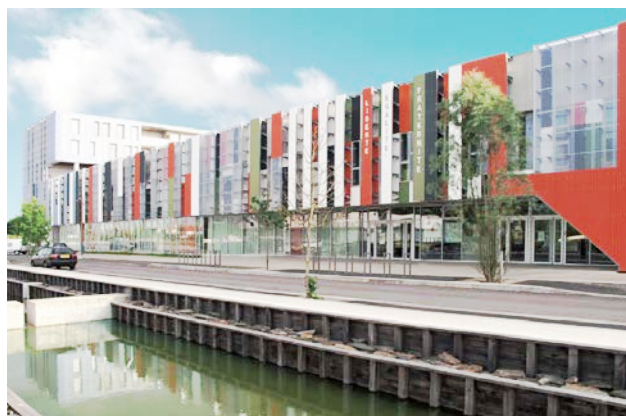
Front urbain sur la face extérieure de l'îlot, mutualisations sur la partie intérieure (Hoogambacht, Dordrecht - Confluence, Lyon - Ilot 11, ZAC Botière)
