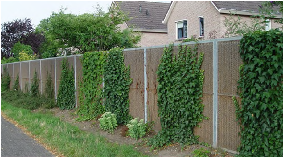
Figure 35 : Exemple de mur anti-bruit végétalisable avec fibres de coco et recouvert par du lierre grimpant (Techni-contact, 2023)
