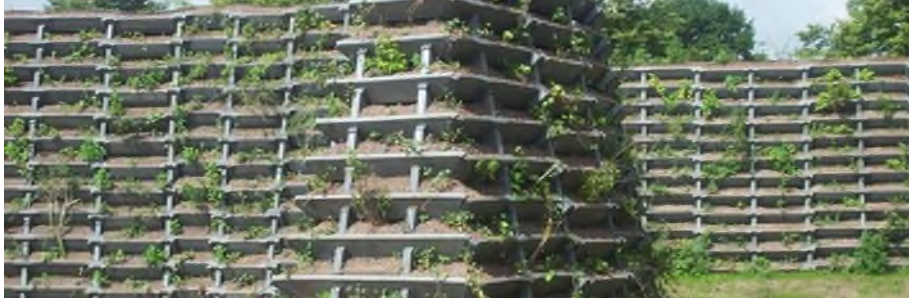
Figure 34 : Exemple de mur anti-bruit végétalisé avec bacs de plantations intégrés (UNaLab, 2023)
