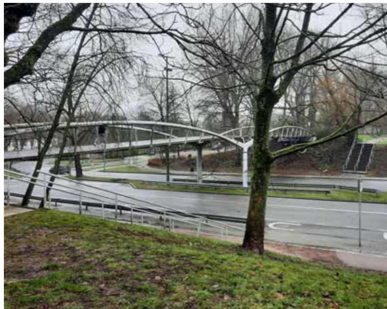
Foto Bestaande toestand Rue de la Corvette
