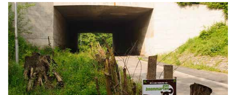
Voorbeeld van een ecopassage: een gecombineerde ecotunnel, waar zowel mens als dier van gebruik kan maken.
