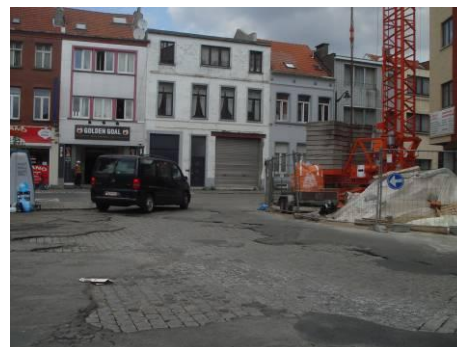
Place Henri Desmet, état du revêtement.
