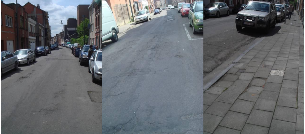
Rue de l'Agrafe, état de l'espace public.
