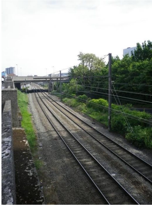
Talus de la ligne 28 vu depuis la dalle rue de Glasgow
