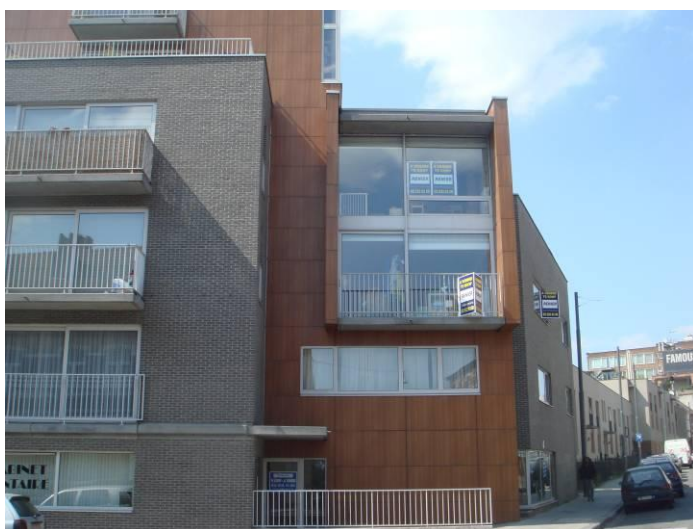
Immeuble neuf rue de l'Agrafe
