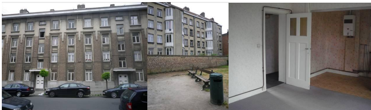
Logements communaux rue Debatty
