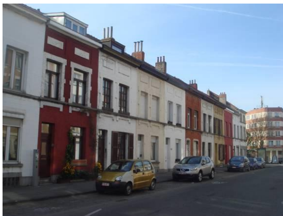
Ensemble de maisons individuelles rue de Birmingham
