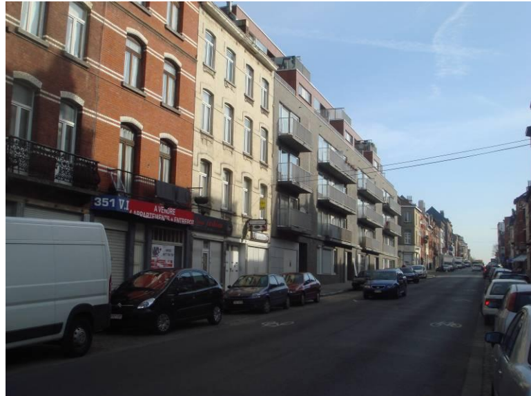
Immeubles rue de Birmingham, secteur Agrafe-Norbert Gille.
