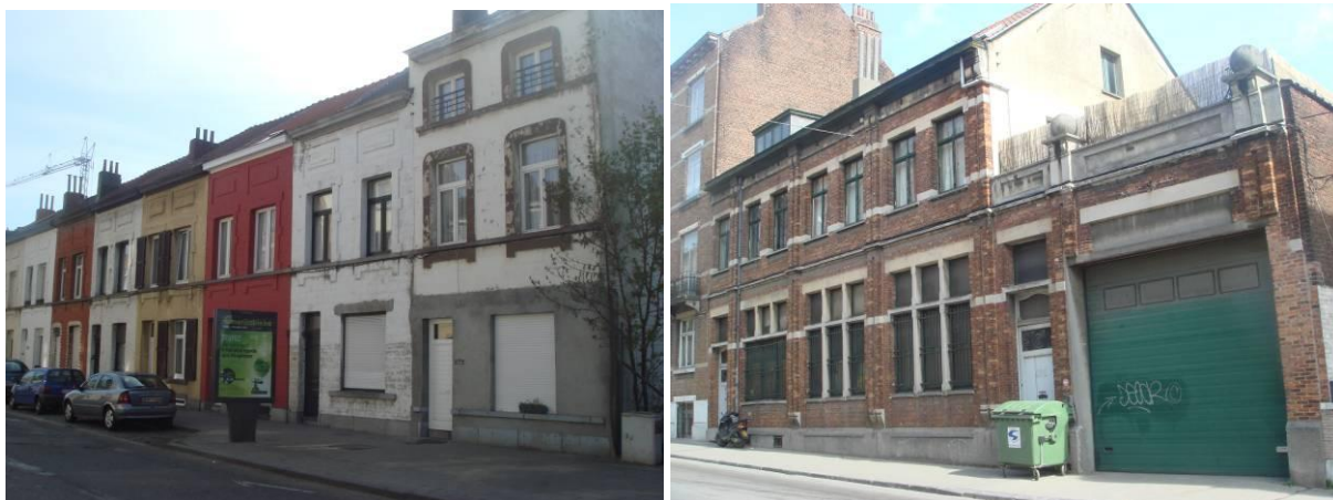
Maisons dégradées rue de Birmingham, rénovées superficiellement, et entrepôt dégradé avenue de Scheut.
