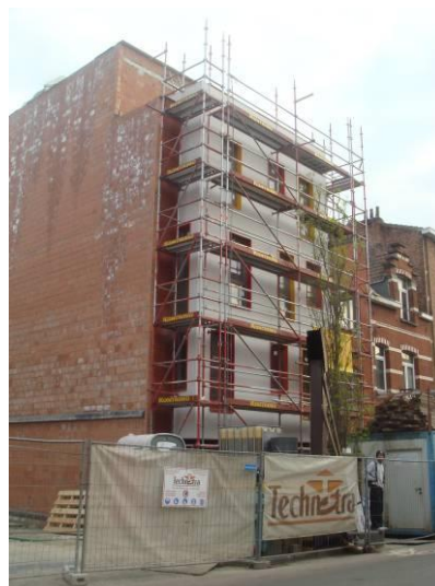
Rénovation de façade – rue d'Aumale
