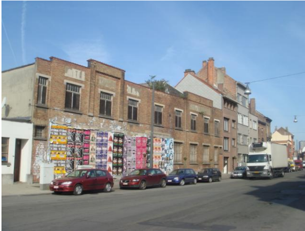
Bâtiment industriel à l'abandon, Avenue de Scheut 22
