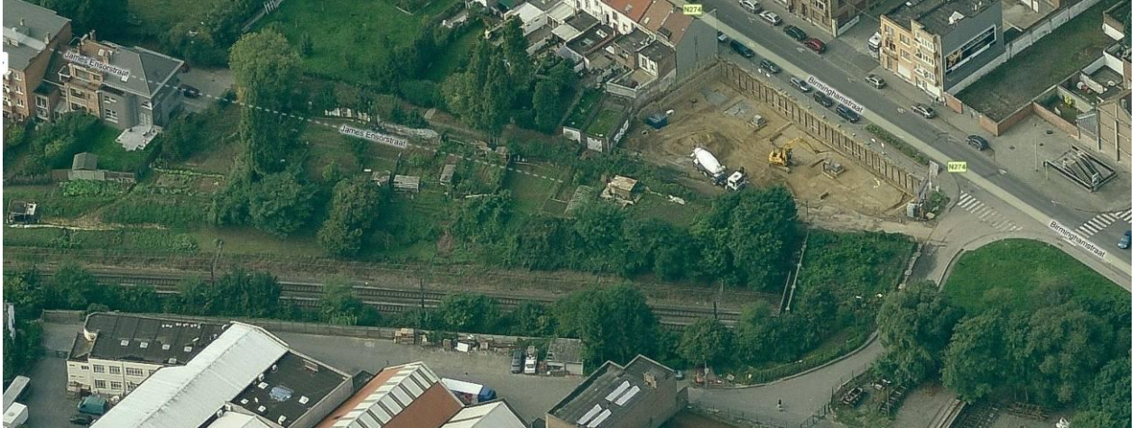
Talus et potagers le long de la ligne 28, rue Ensor
